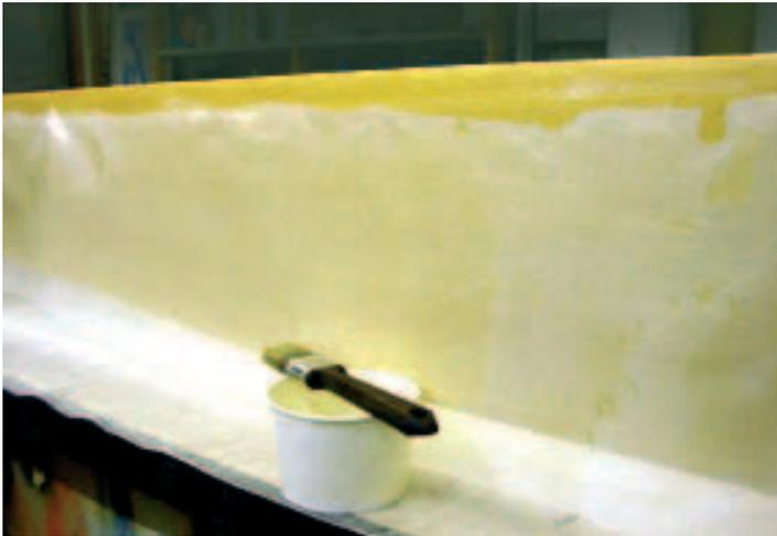
Auf der Tragfläche aufgetragen verdunstet das Methanol sehr rasch und übrig bleibt ein dünner Harz-Film.
